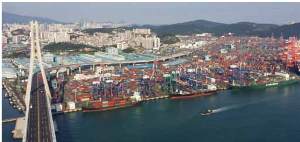
Prístav v Pusane – pohľad z mosta Hangang
